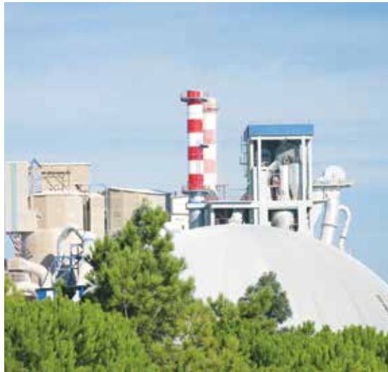
/ Fornos da Fábrica Cibra-Pataias
