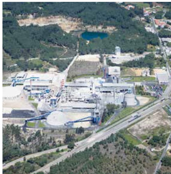
/ Vista aérea da Fábrica Cibra-Pataias
