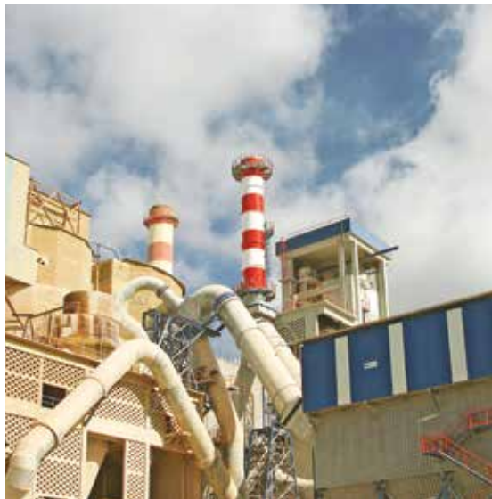
/ Fornos da Fábrica Cibra-Pataias
